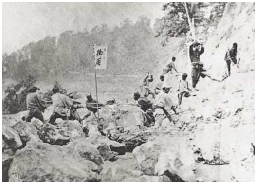
札幌本道の開削状況
