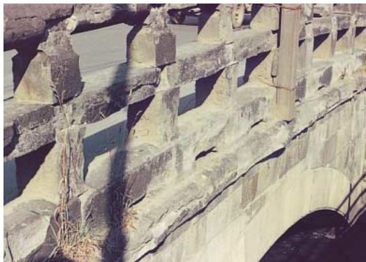
永年の風雪によってボロボロに欠けた高欄
