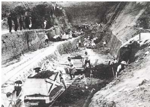
朝里トンネル入口付近の人力による作業状況
