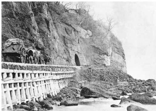
当時の海岸道路（写真提供：北海道大学北方資料室）
