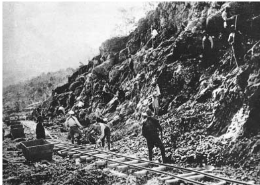
爆薬挿填穴作業（写真提供：札幌国道写真帳より）
